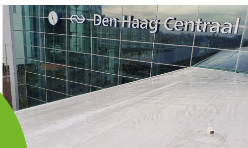
Busplatform - Centraal Station Den Haag
